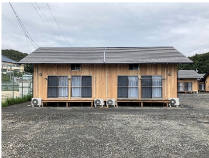
【写真1】総社市に移築された木造仮設住宅
