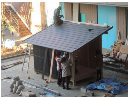
柿渋塗装した木壁と銅版屋根の設置
